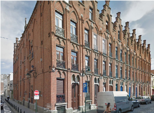
Figuur 2: Een reeks van elf opbrengsteigendommen getekend door G. Cochaux in 1898 (rue de la Poudrière, 1000 Brussel). Achter hun neogotische gevels gekenmerkt door trapgevels, verbergen zich schrale appartementen voor de arbeidersklasse. (source: Google Maps)
