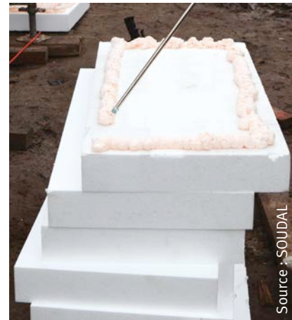
5 | Encollage des panneaux d'isolation à l'aide de mousse-colle PU.
