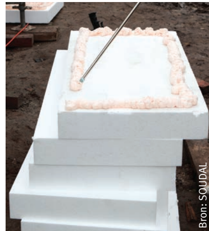
5 | Verlijming van de isolatieplaten met PU-lijmschuim.
